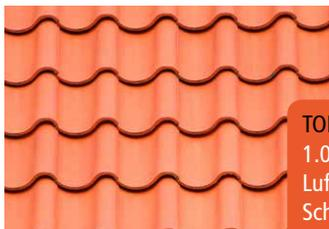
TONZIEGEL werden bei 1.000 Grad aus Wasser, Luft und Tonerde gebrannt. Schöne Wirkung, wenn sie verwittern..
