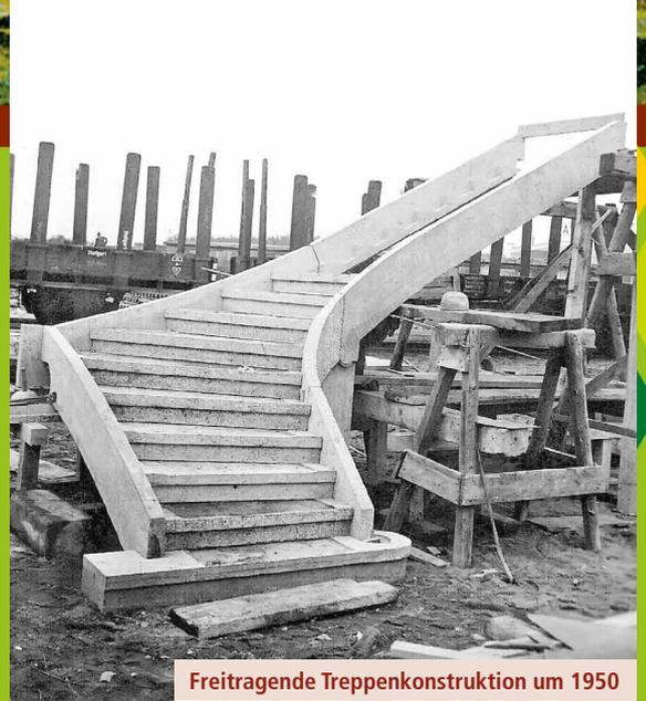
Freitragende Treppenkonstruktion um 1950
